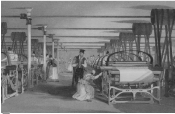
Telai meccanici in uno stabilimento tessile - J. Tingle (Public Domain)
